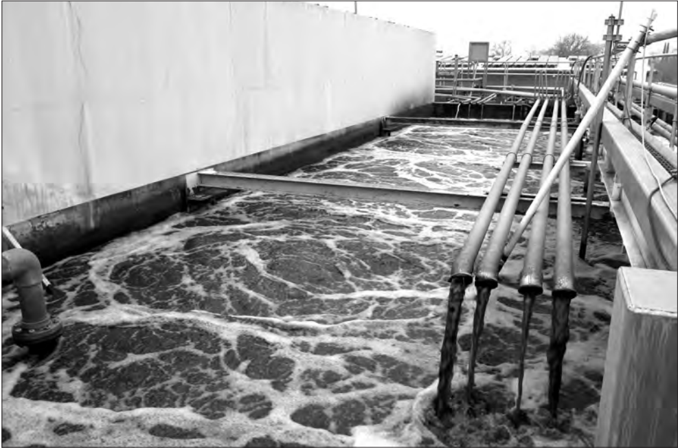
Figura 7 - Questo è il serbatoio di digestione aerobica di Sierra Nevada Brewing Co. a Chico, in California.
